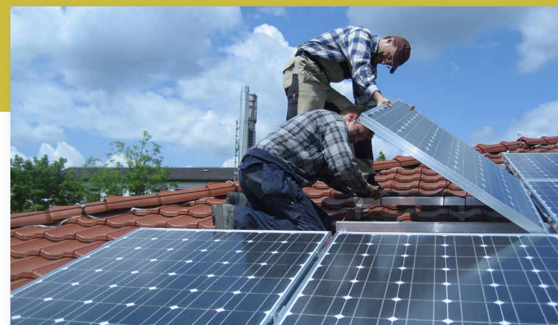
Solaranlagen werden auf dem Kindergarten montiert.
