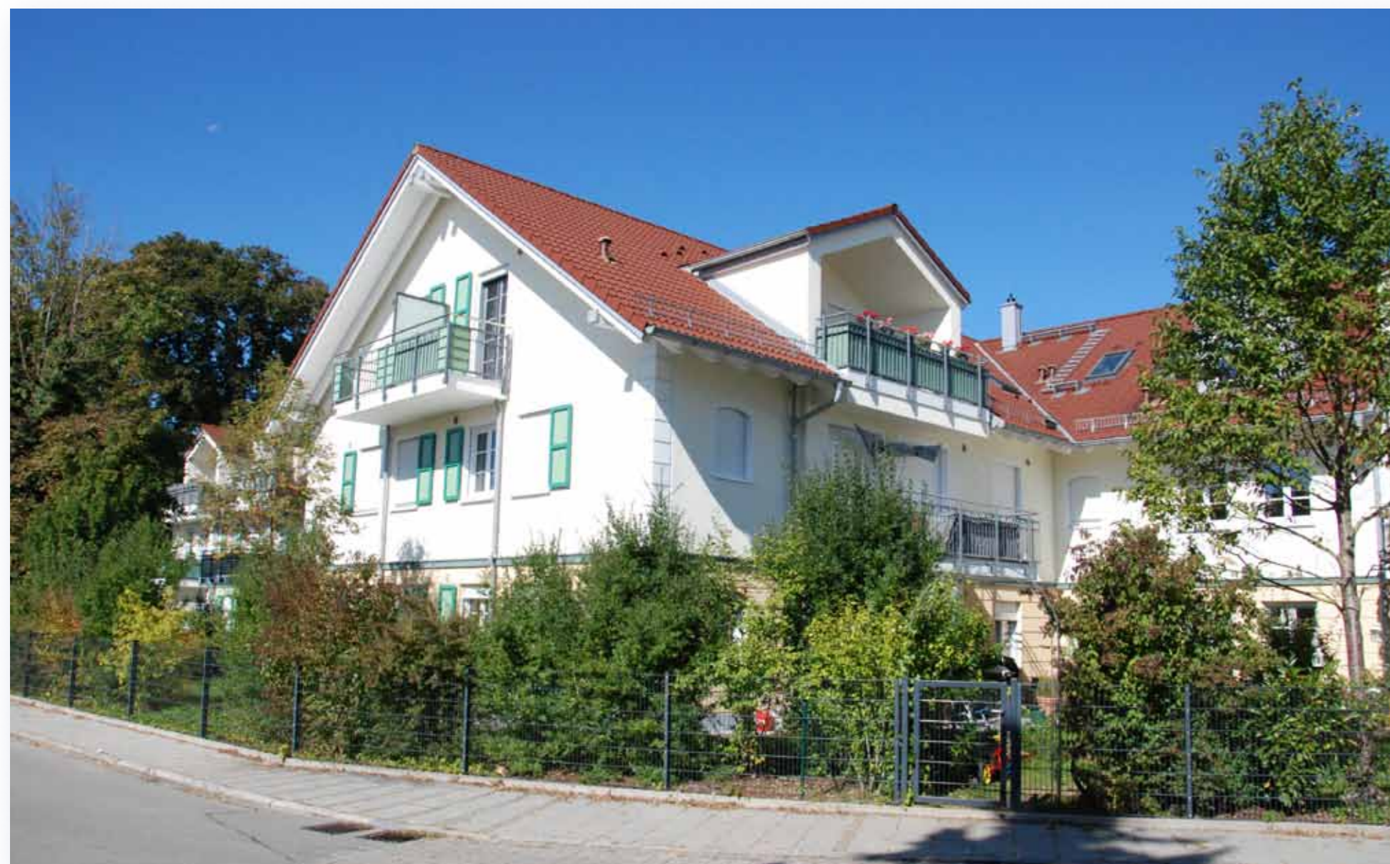
Neubau im Bestand, mit gelungener Einbindung in die Umgebung, Oedenstockach.
