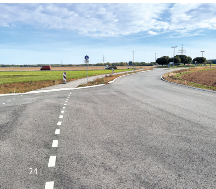
Verlängerung der Hermann-Oberth-Straße
