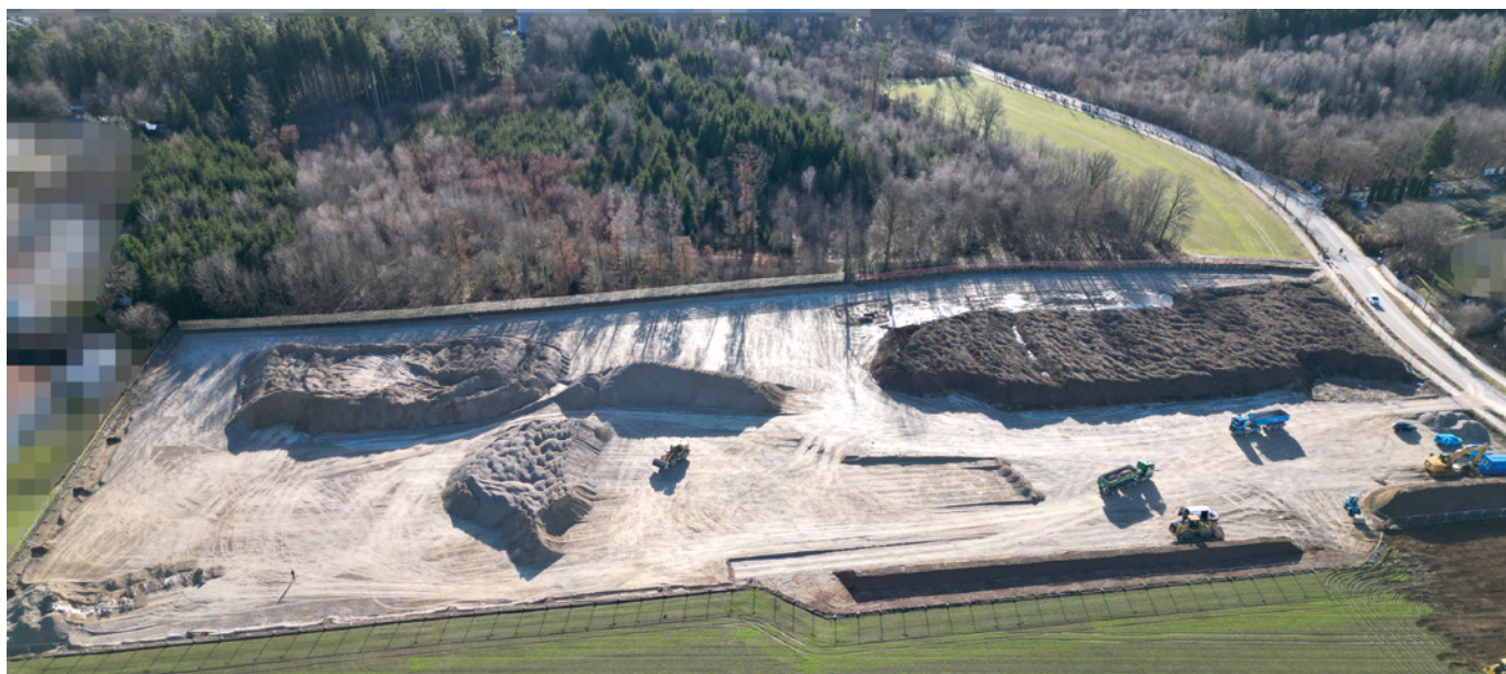
Erdarbeiten „Gymnasium an der Oedenstockacher Straße“
