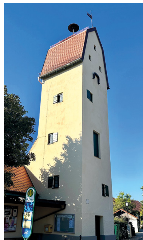
Sanierung Fassade Wasserturm
