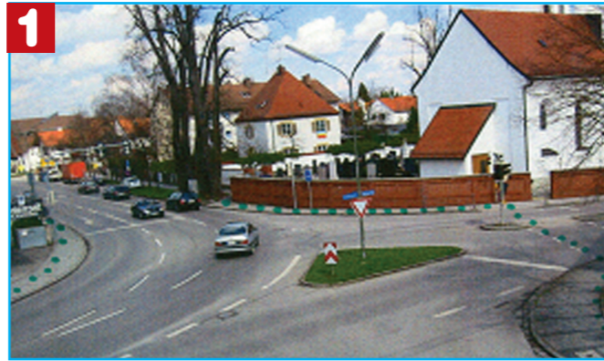
1 Ampelanlage Hohenbrunner Straße / Glonner Straße / Rathausstraße
